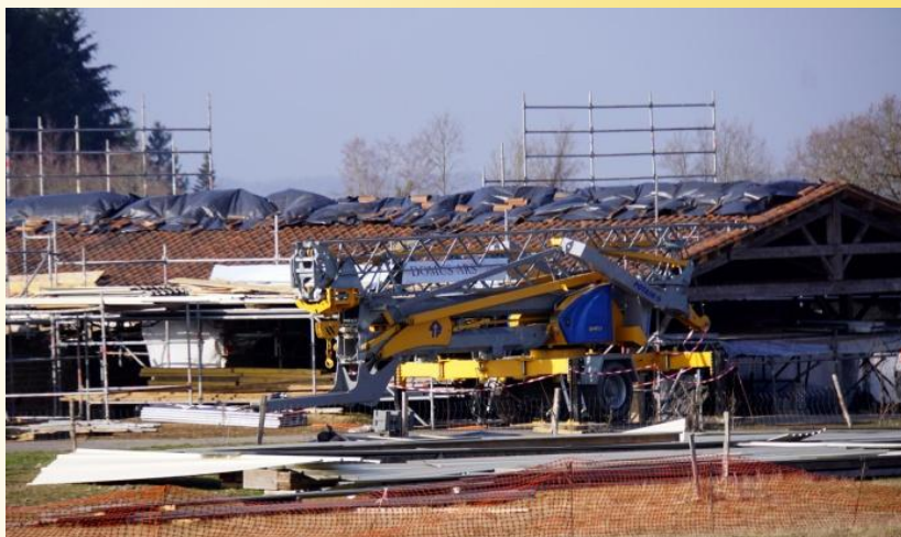
Travaux de remise en place de la couverture de tuiles – janvier 2017 - photo JC Barthout
