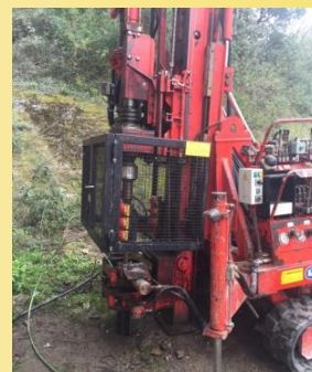
Récupération des boues de forages
