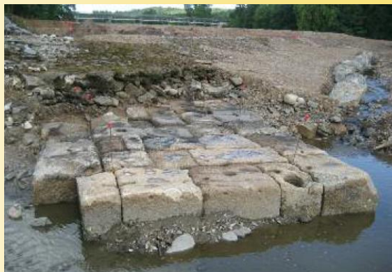
Dégagement d'une pile du pont romain
